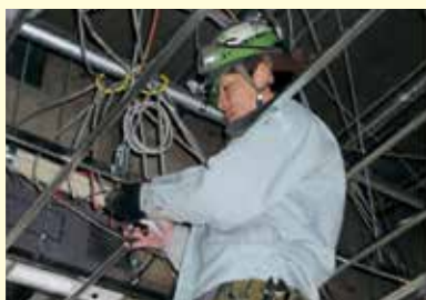
屋内配線工事の様子
