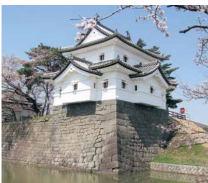
地域の熱意や思いとともに新発田城 辰巳櫓復元工事に参画。高い建築技術で見事に往事の姿を再現した。一般公開されており、内部の様子が見学できる。
